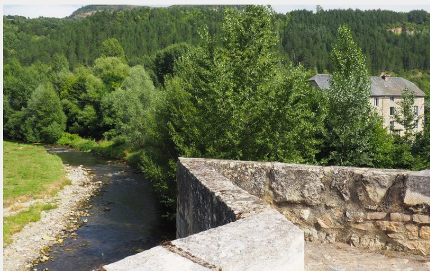
Pont sur la Colagne (© OTCCGD)
